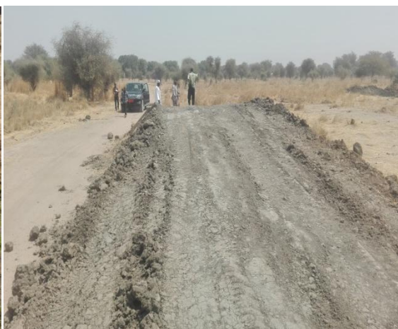
Photo 14: Travaux de cantonnage d'une route secondaire
